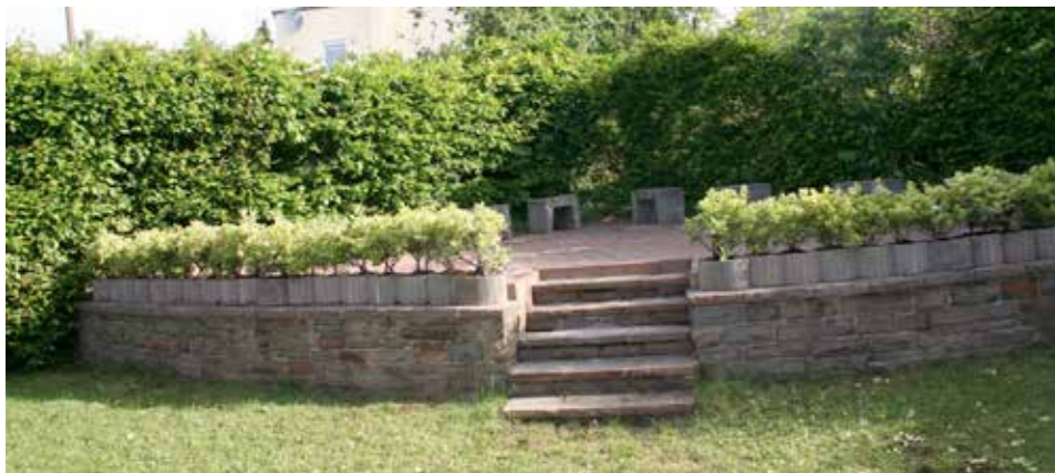
Erstrahlt wieder nach Renovierung: das Podest hinter dem „Jugendheim“ in Sankt Gallus. Foto: Dorothee Wendt
